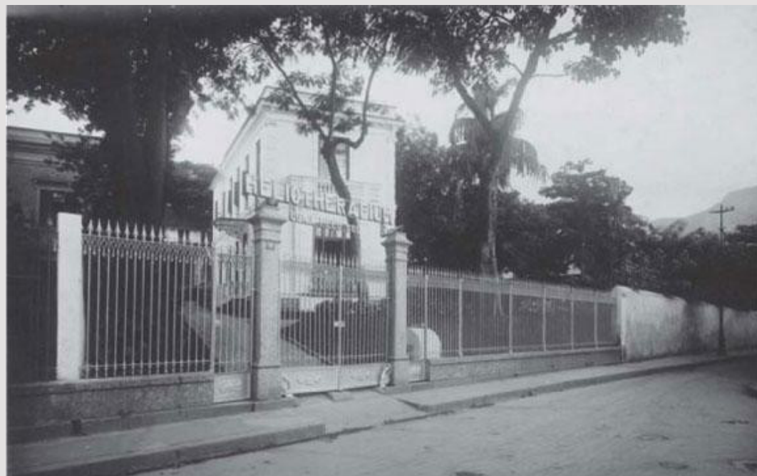
FIGURA 101 Fachada do Heliotherapium
